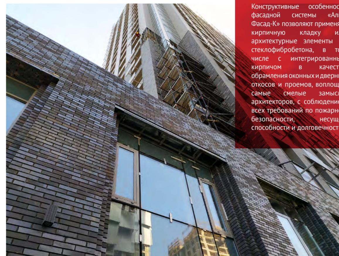
Конструктивные особенности фасадной системы «Альт-Фасад-К» позволяют применять кирпичную кладку или архитектурные элементы из стеклофибробетона, в том числе с интегрированным кирпичом в качестве обрамления оконных и дверных откосов и проемов, воплощая самые смелые замыслы архитекторов, с соблюдением всех требований по пожарной безопасности, несущей способности и долговечности.
